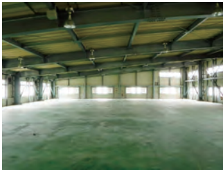
1階工場部分内観
