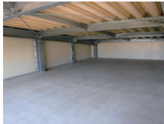
2階倉庫部分内観
